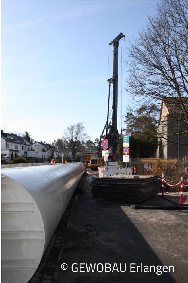
Das Nahwärmenetz wird über sogenannte Hochleistungsenergiepfähle (HEP) mit Wärme versorgt. Die Energiepfähle sind ca. 28 Meter lang und haben einen Durchmesser von 1,42 m. Insgesamt werden vier Hochleistungsenergiepfähle der Firma TerraCool GmbH verbaut.
